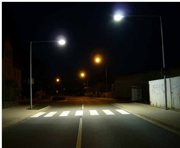
Obr. 4 – Osvětlení přechodu pro chodce
