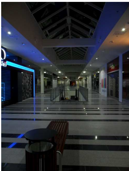
Obr.6. Núdzové osvetlenie kombináciou žiaroviek a LED.
